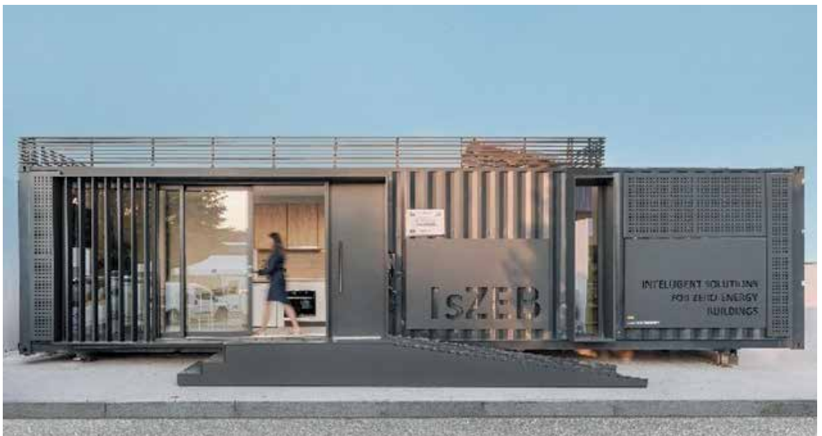
Το container του IsZEB Cluster, όπου η έρευνα για τα ευφυή κτίρια και τον Δείκτη Ευφυούς Ετοιμότητας (SRI) περνά στην πράξη και στην αγορά.
